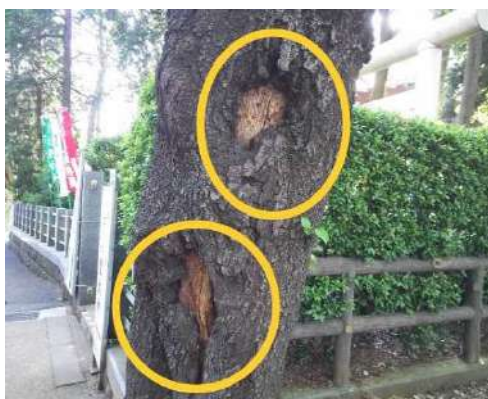
写真：幹の亀裂の様子（桜の木）
