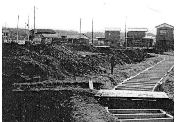
写真3 下麻生住宅建設のための開発現場
