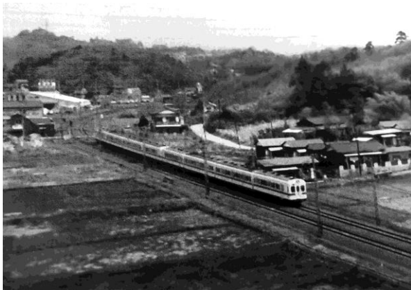
写真4 工事中の新百合ヶ丘駅(右手山中)付近を走る小田急線
