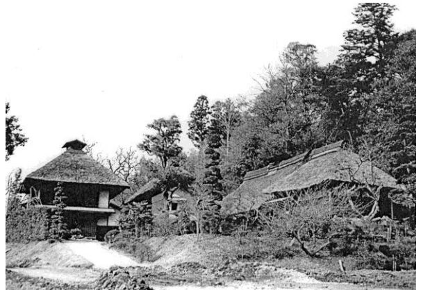
写真2 藁ぶき屋根の豪農の母屋と蔵(正面) (栗木)
