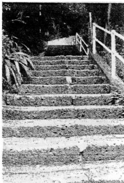
昔の正門への階段道
