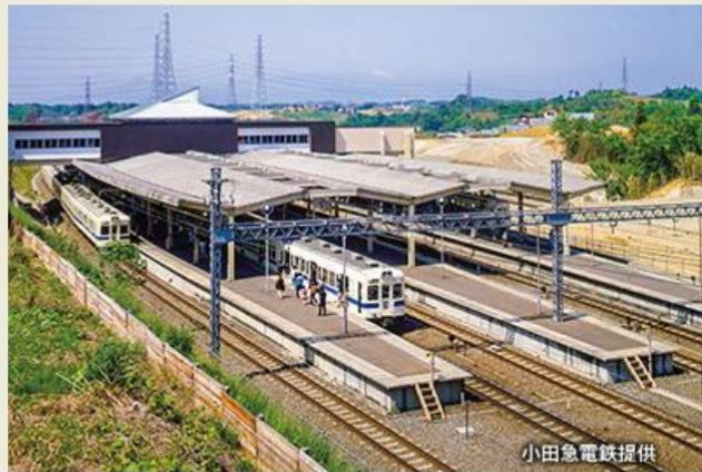
写真は 1978(昭和 53)年撮影の「新百合ヶ丘駅」。駅の北側(写真右奥)で造成工事が始まっている。
