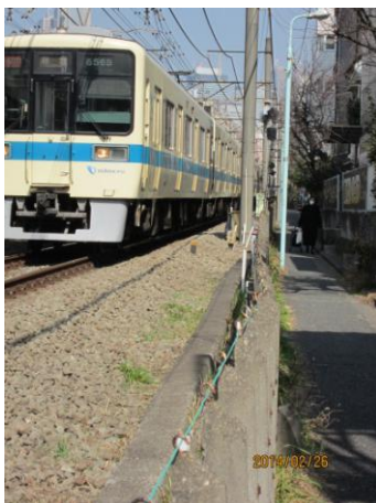
現在の小田急線と小道(河骨川) (コンクリとアスファルトの暗渠)
